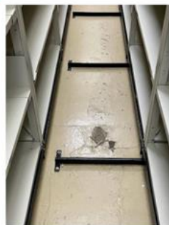
Deterioros significativos de los pisos.
