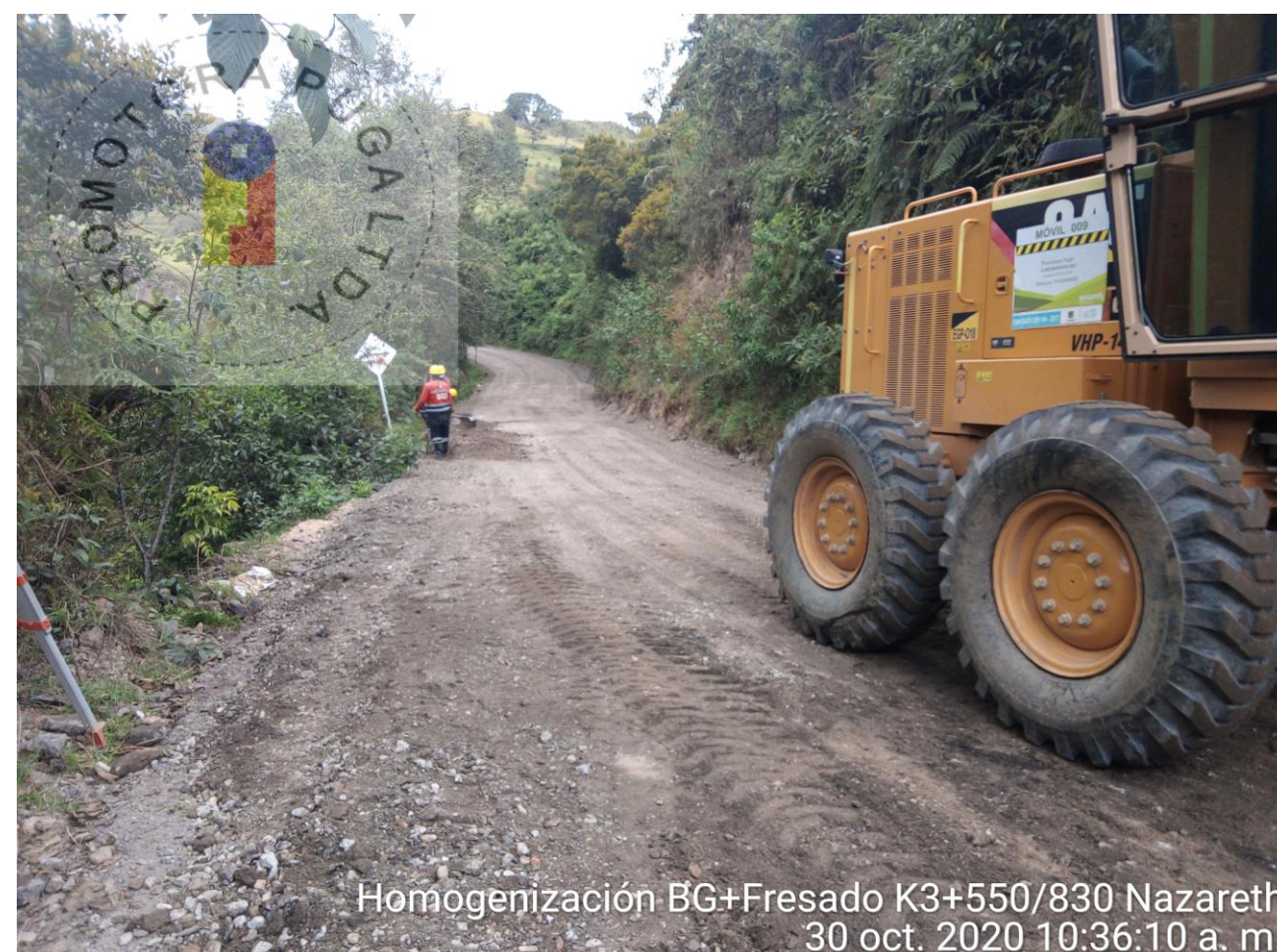
HOMOGENIZACIÓN BG + FRESADO K3 +550 – K3 830
