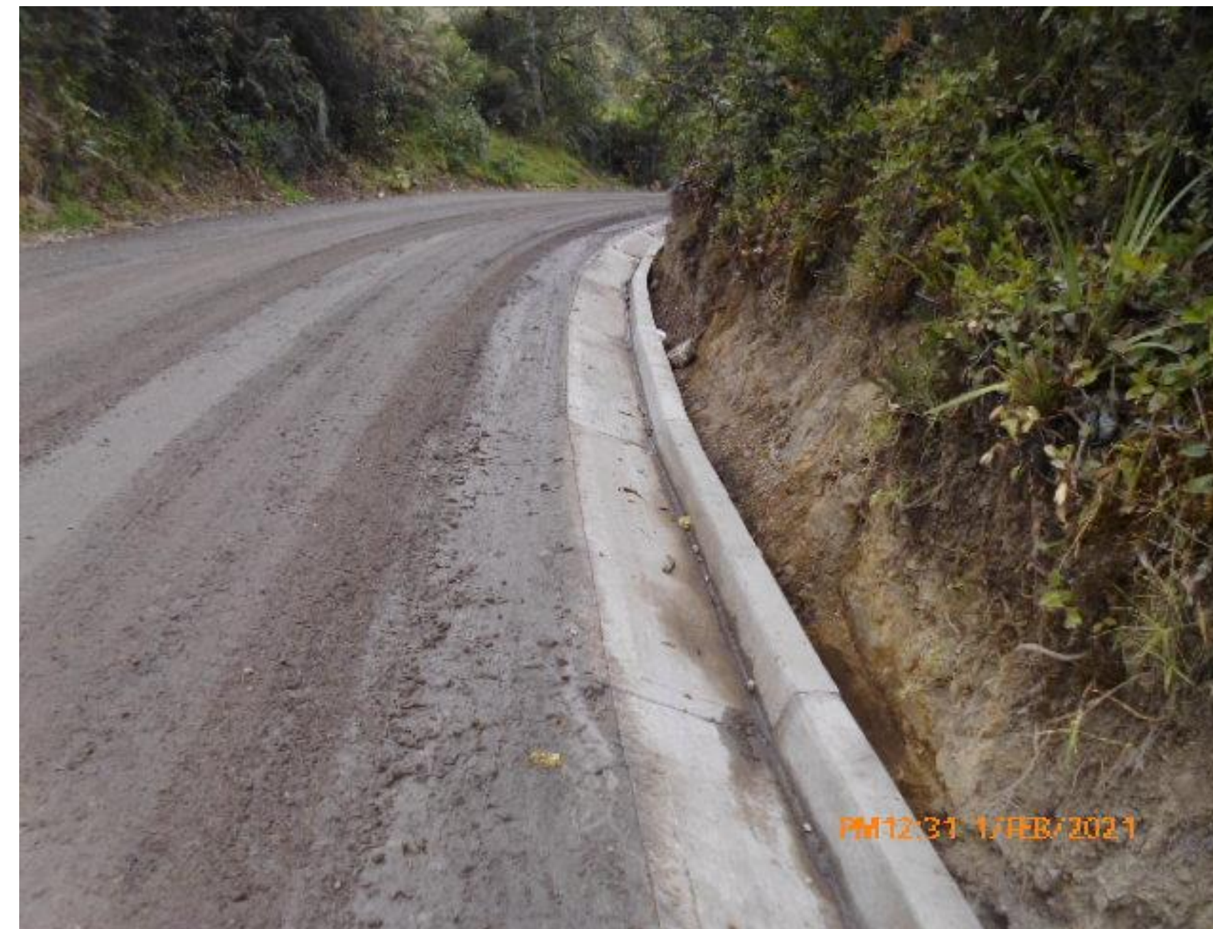
CONSTRUCCIÓN DE CANALETA MANTENIMIENTO PERIODICO
