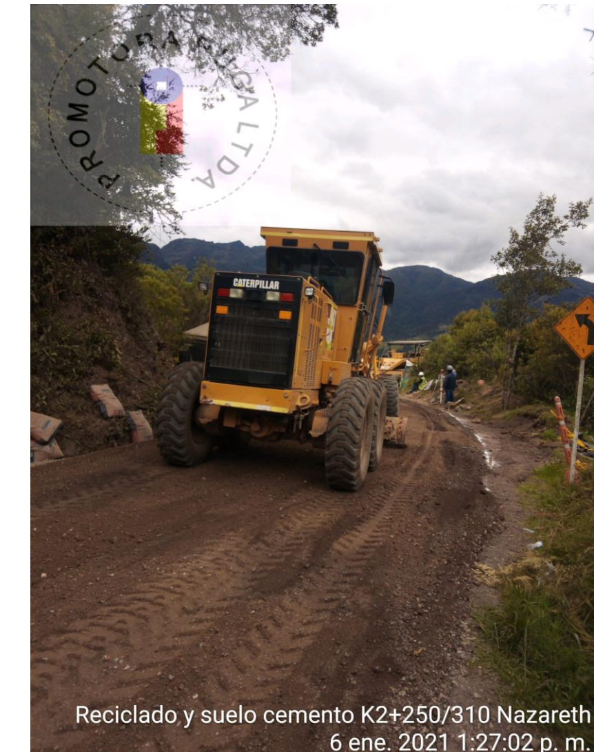
K2+250 HASTA K2+ 310 Reciclaje de pavimento y cemento al 3%
