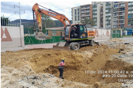
Excavación de lumbrera para ubicación de box existente
