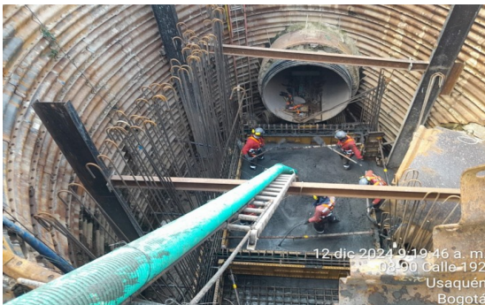
Fundida concreto 4000 psi placa fondo cámara B69
