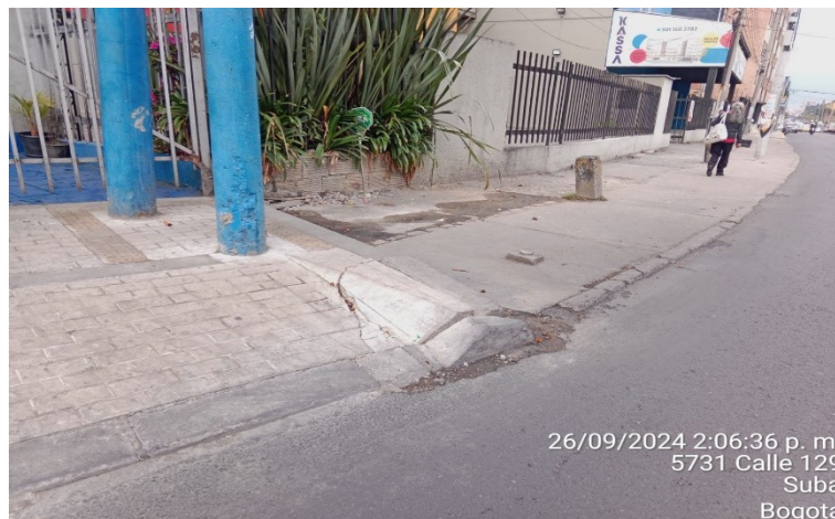
Fotografía No 1 Verificación afectación de sardineles y hombro de la rampa por daños vehículos Calle 129 CR 57
