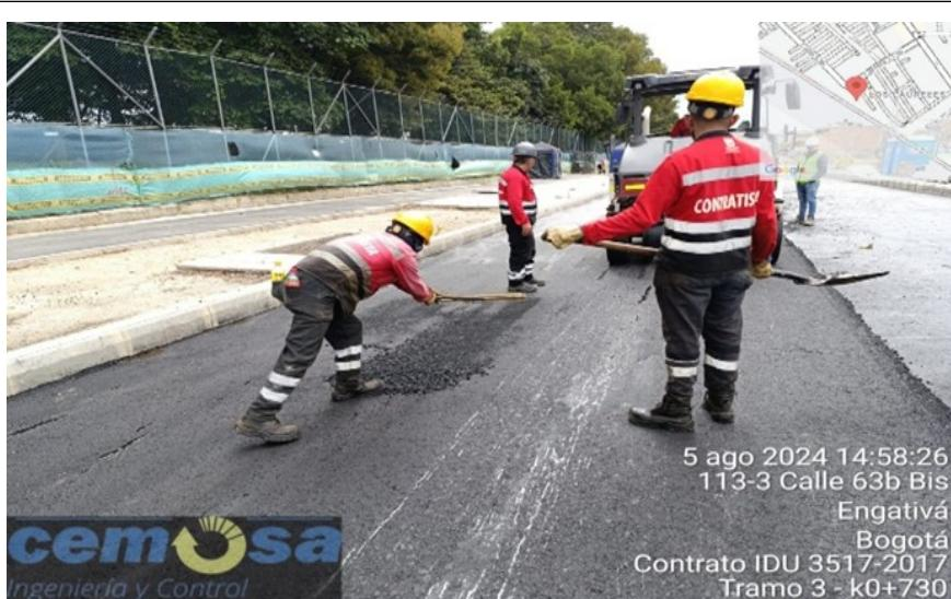
INSTALACIÓN DE EMULSIÓN ASFÁLTICA PARA LA INSTALACIÓN DE MEZCLA
