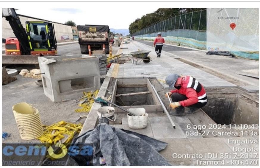
INSTALACIÓN DE PARTE INFERIOR DE SUMIDERO PREFABRICADO EN LA
