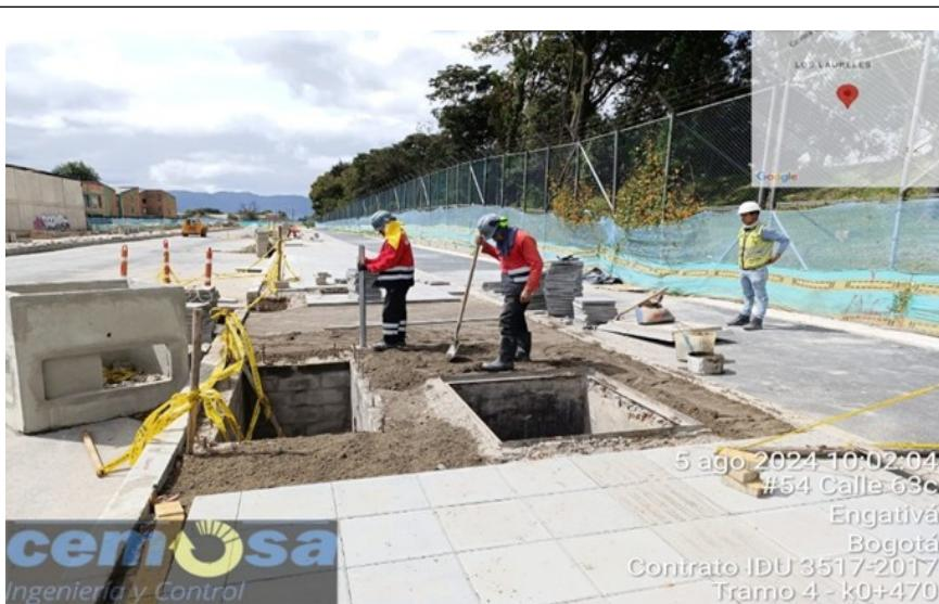
INSTALACIÓN DE ARENA DE SOPORTE PARA LA INSTALACIÓN DE LOSETAS PREFABRICADAS EN EL COSTADO SUR
