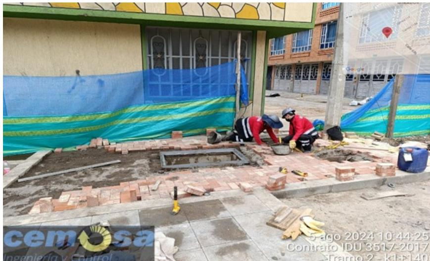
INSTALACIÓN DE ADOQUÍN DE ARCILLA EN EL COSTADO NORTE ZONA DE
