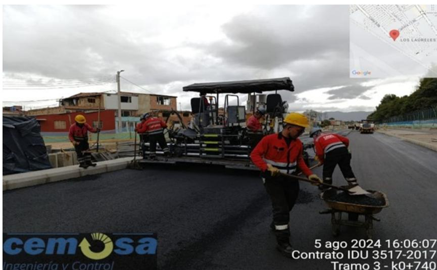
INSTALACIÓN DE MEZCLA ASFÁLTICA (MD12) EN LA CALZADA SUR EN EL K0+760 A K0+680 EN EL TRAMO III DE LA OBRA.
