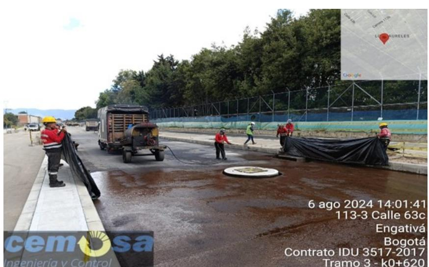
INSTALACIÓN DE EMULSIÓN ASFÁLTICA EN LA CALZADA SUR PARA LA
