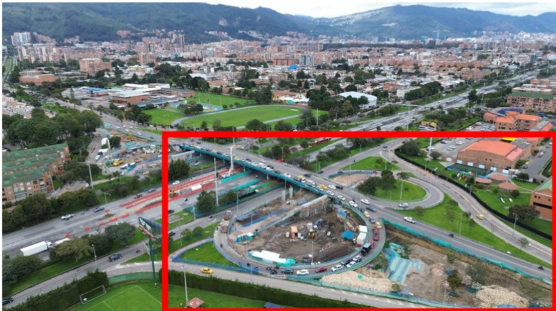
Foto 2. Estado actual campamento de obra costado occidental. Construcción de oreja de acceso al puente
