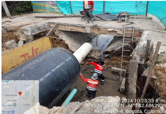
Perfilación de suelo para fundida de solado Canal Canaima K1+950.
