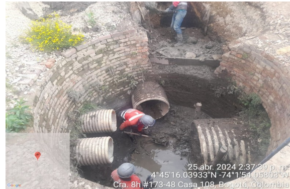
Retiro de lodos y alistamiento de terreno para instalación de Cámara de polietileno HD, Canal Redil K0+640
