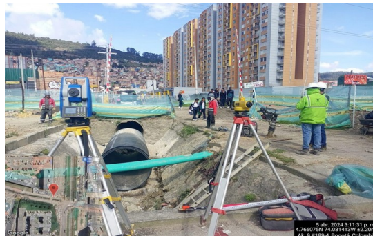
Instalación Tubería 1,6m canal Canaima K1+950
