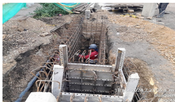
Amarre de hierro y encofrado para fundida de
