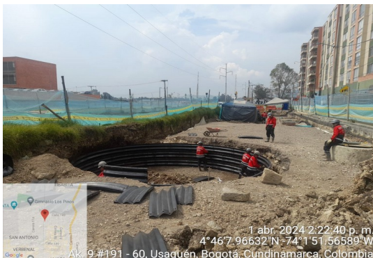
Exvacación Lumbrera para Linner K2+280 Red Pluvial.
