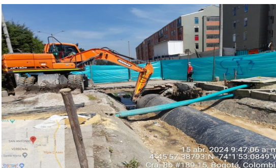
Instalación y rellenos tubería de 1,6m K1+950 sumidero
