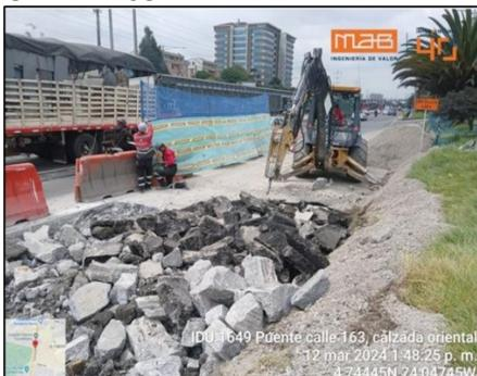
**Sector calle 163.** Actividades de demolición de pavimento existente para la mejora geométrica junto a separador oriental.
