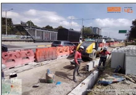
**Sector calle 163.** Instalación de sardinel pre fabricado tipo A10 en el separador oriental de la mejora geométrica.
