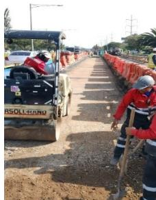
**Sector Calle 146:** Actividades de compactación de material remanente en el sector de la mejora geométrica del carril central. Instalación de geomalla para estructura de pavimento en carril central de la mejora geométrica y compactación de material granular de subbase.
