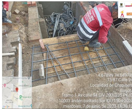
Actividad: Figurado de acero para estructura de caja CS277. Localización: Tramo 1 Calle 94 entre la Carrera 15 y Carrera 13 Andén costado sur.
