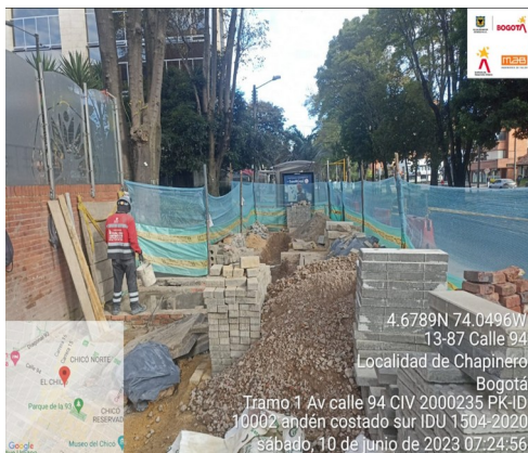
Actividad: Conformación de estructura de espacio público y nivelación de infraestructura de redes. Localización: Tramo 1 Calle 94 entre la Carrera 15 y Carrera 13 Andén costado Sur
