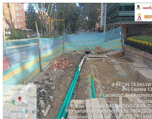
Actividad: Excavación manual e instalación de tubería redes secas.
