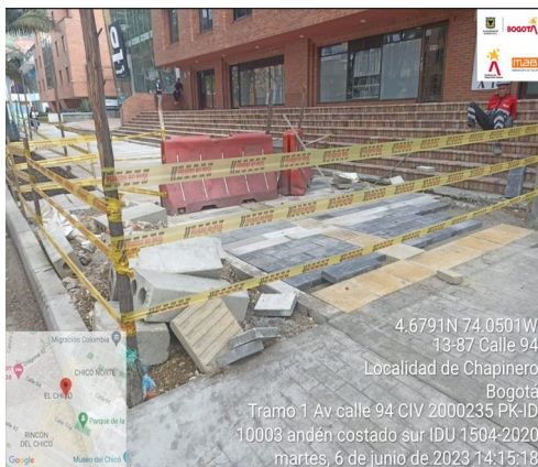
Actividad: Instalación de loseta bicapa A40 y táctil y guía A55y A56. Localización: Tramo 1 Calle 94 entre la Carrera 15 y Carrera 13 Andén costado Sur.
