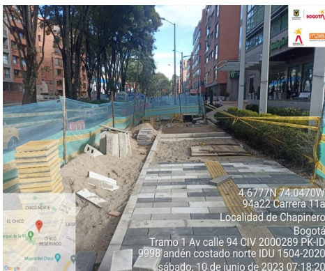
Actividad: Verificación de loseta A40 en espacio. Localización: Tramo 1 Calle 94 entre la Carrera 13 y Carrera 11 Andén costado Norte
