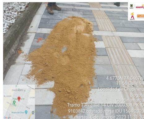
Actividad: Verificación de sello de loseta sobre separador. Localización: Tramo 1 Calle 94 entre la Carrera 13 y Carrera 11 Andén Norte.
