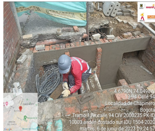
Actividad: Conformación de caja CS277 Localización: Tramo 1 Calle 94 entre la Carrera 15 y Carrera 13 Andén costado Sur.
