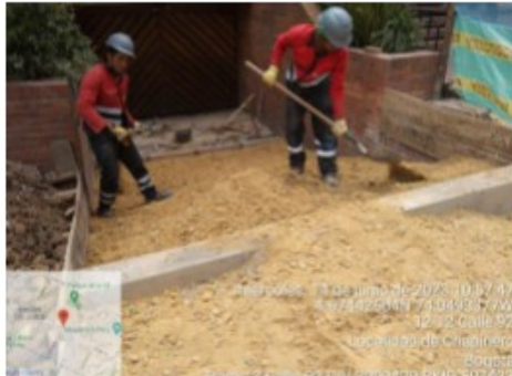
Imagen No.5 Instalación de Base granular clase A.
