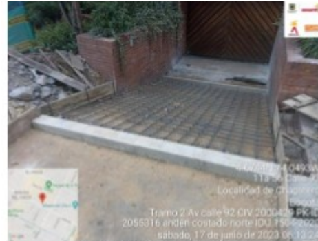
Imagen No.6 Instalación de acero de refuerzo
