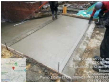
Imagen No.7 Vaciado de rampa vehicular con concreto hidráulico MR 4 MPa
