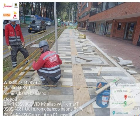
Descripción: Instalación de loseta bicapa A-40 en Localización: Tramo 1 Calle 94 entre la Carrera 13 y Carrera 11 Andén costado Norte.
