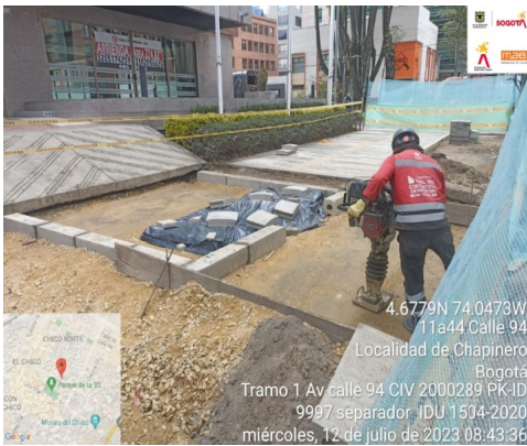
Descripción: Compactación de base granular para Construcción de rampa vehicular. Localización: Tramo 1 Calle 94 entre la Carrera 13 y Carrera 11 Anden costado Norte
