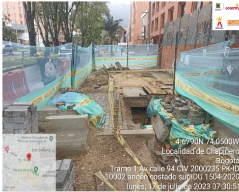
Descripción: Excavación manual para conformación de Espacio público. Localización: Tramo 1 Calle 94 entre la Carrera 15 y Carrera 13 Anden costado sur.
