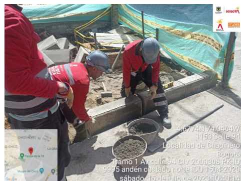
Descripción: Instalación de sardinel A-10 en borde de Vía.
