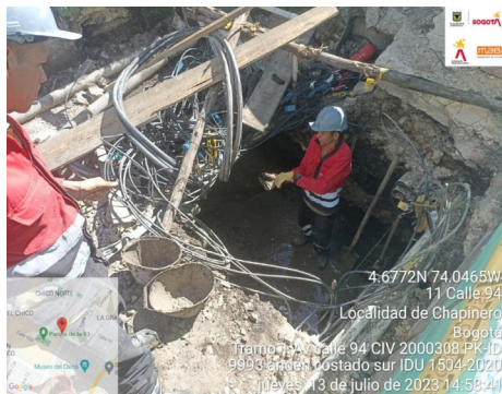
Descripción: Excavación manual para construcción de Caja CS 276 en espacio público.
