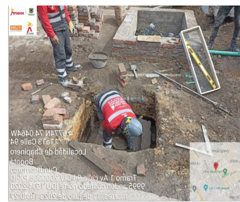
Descripción: Construcción de caja CS 274 Localización: Tramo 1 Calle 94 entre la Carrera 13 y Carrera 11 Anden Norte.
