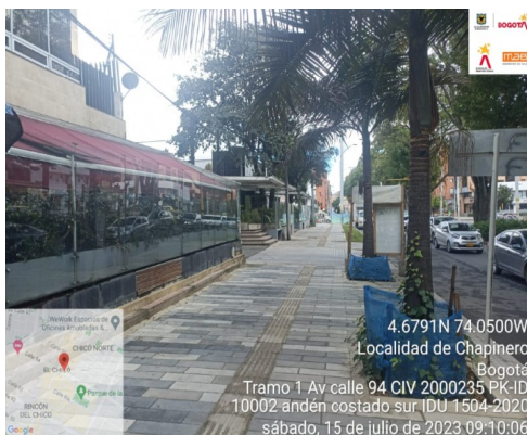
Descripción: Instalación de loseta bicapa A-40 en espacio público. Localización: Tramo 1 Calle 94 entre la Carrera 15 y Carrera 13 Andén costado sur
