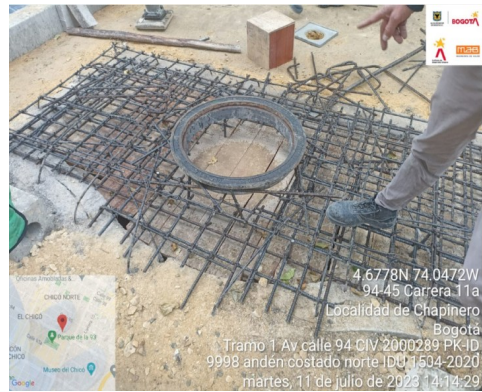
Descripción: Instalación de acero de refuerzo para Construcción de cámara de ETB en espacio público. Localización: Tramo 1 Calle 94 entre la Carrera 13 y Carrera 11 Anden costado Norte.
