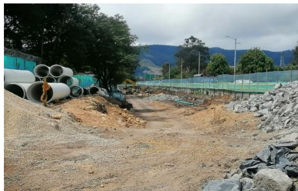
**Tramo 2 (Canal Córdoba a Kr 58 Proyección Av. Villas):** Se realizó la excavación del cajón de la vía y se instaló rajón para conformación de la estructura de la misma, se instalaron las redes sanitarias. Actualmente se avanza en la excavación y conformación del espacio público, así como la instalación de redes secas. En la vía se avanza en la colocación de sub base y base granular.
