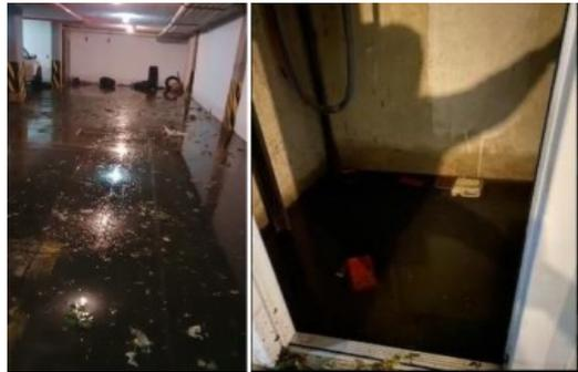
3. *Pendiente inapropiada para desagüe de aguas lluvias, alcantarilla no operativa y material de obra que tapa la única alcantarilla del sector. Este sector solo cuenta con 1 alcantarilla operativa.*
