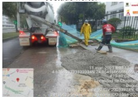
Imagen No.1 Vaciado de concreto para rampa de acceso calle 92 con carrera 18 costado norte.
