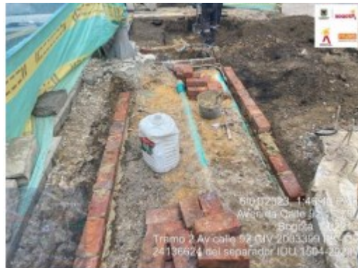
Fotografía No.13 Instalación de arena de peña para cárcamo calle 92 entre carrera 15 y carrera 16
