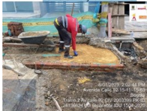
Fotografía No.13 Instalación de arena de peña para cárcamo calle 92 entre carrera 15 y carrera 16
