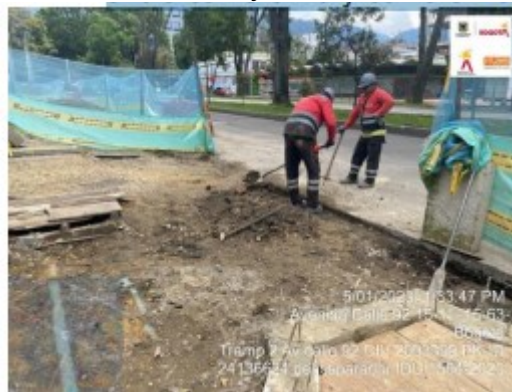
Fotografía No.11 Excavación manual para instalación de bordillo calle 92 entre carrera 15 y carrera 16.
