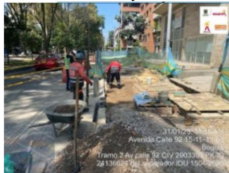
Fotografía No.7 Instalación y compactación de subbase granular PEA calle 92 entre carrera 15 y carrera 16.
