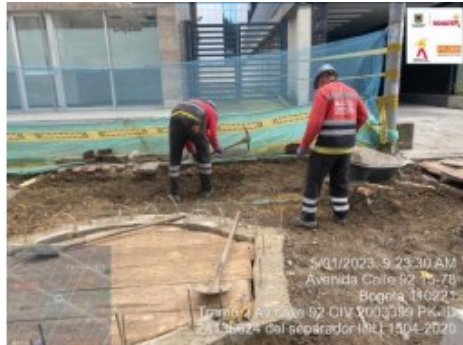
Fotografía No.11 Excavación manual para instalación de bordillo calle 92 entre carrera 15 y carrera 16.
