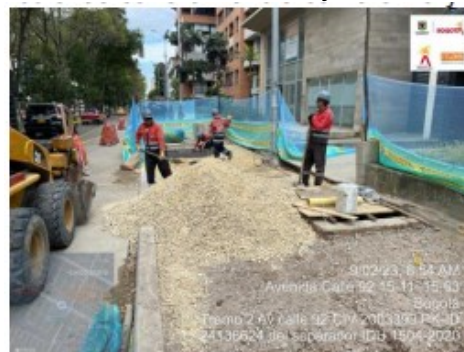
Fotografía No.3 Instalación de subbase granular PEA para espacio público calle 92 entre carrera 15 y carrera 16.
