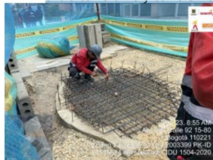
Fotografía No.5 Instalación de acero de refuerzo para tapa de caja calle 92 entre carrera 15 y carrera 16.
