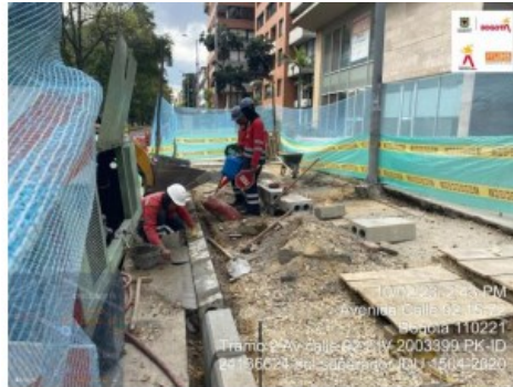
Fotografía No.3 Instalación de subbase granular PEA para espacio público calle 92 entre carrera 15 y carrera 16.
