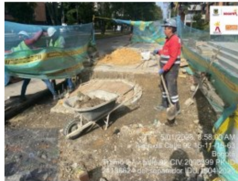
Fotografía No.9 Retiro de material de excavación calle 92 entre carrera 15 y carrera 16.
