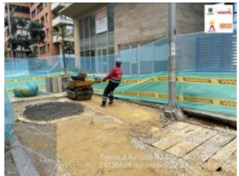
Fotografía No.7 Instalación y compactación de subbase granular PEA calle 92 entre carrera 15 y carrera 16.
