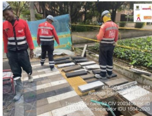
Imagen No.6 instalación de losetas en paño calle 92 con carrera 13A.
