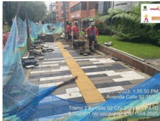
Imagen No.4 conformación de andenes calle 92 con carrera 15.
