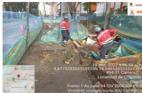
Imagen No.14 Demolición de material para construcción de cajas calle 94 entre la carrera 10 y carrera 11.
