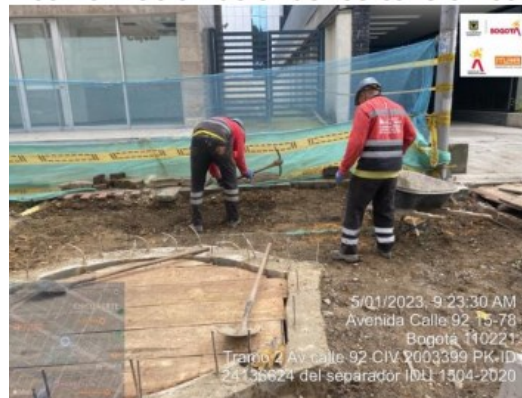
Imagen No.4 conformación de andenes calle 92 con carrera 15.
