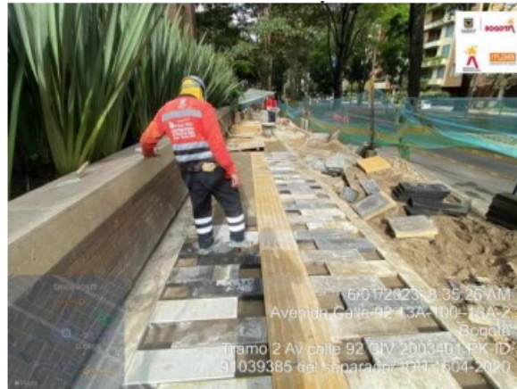
Imagen No.6 instalación de losetas en paño calle 92 con carrera 13A.
