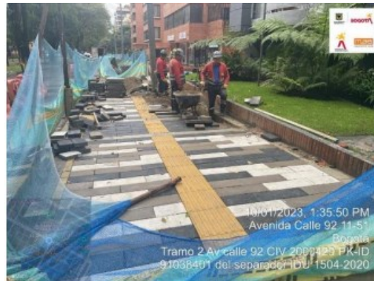
Imagen No.3 Instalación de loseta en paño de andenes calle 92 con carrera 11.
