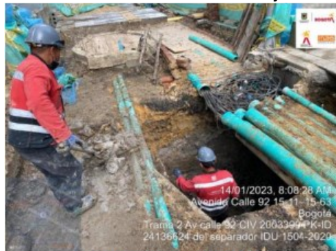
Imagen No.10 Excavación manual para construcción de caja CS 280 en espacio público calle 92 entre la carrera 18 y carrera 15.
