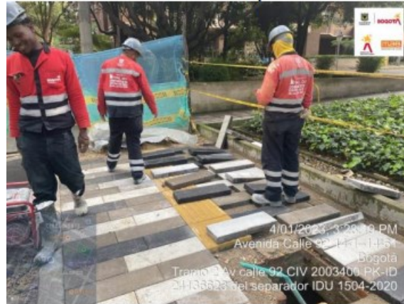
Imagen No.5 instalación de losetas en paño calle 92 con carrera 14.
