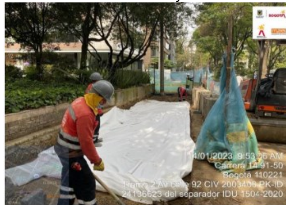
Imagen No.7 Instalación de geotextil para conformación de espacio público calle 92 entre la carrera 15 y carrera 13ª.
