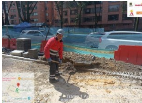
Imagen No.13 Conformación de subbase PEA espacio público calle 94 entre la carrera 11 y carrera 12.
