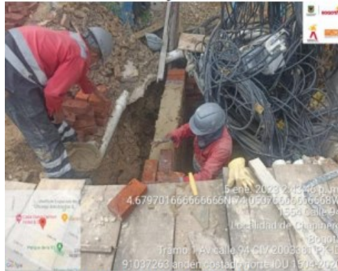
Imagen No.11 Construcción de caja CS 276 en espacio público calle 94 entre la carrera 16 y carrera 15.
