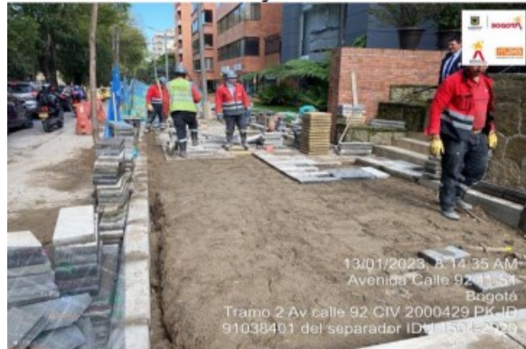
Imagen No.9 Instalación de loseta bicapa A-40 en espacio público calle 92 entre la carrera 12 y carrera 11.
