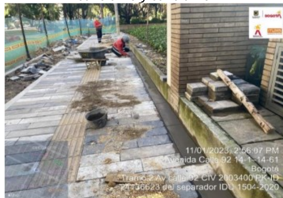
Imagen No.8 Construcción de cinta de ajuste en espacio público calle 92 entre la carrera 15 y carrera 13ª.
