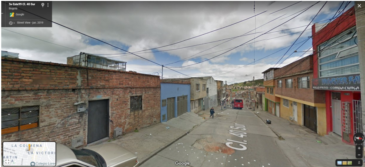
Figura 133 - Situación Actual Carrera 3 Este - Estación la victoria
