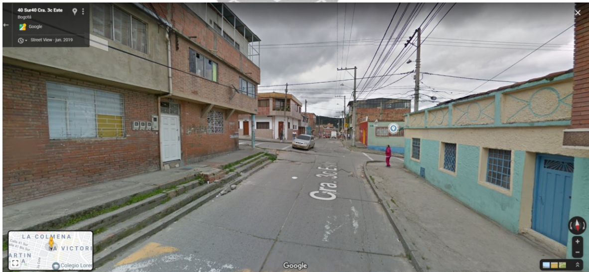
Figura 132 - Situación Actual Carrera 3 Este - Estación la victoria
