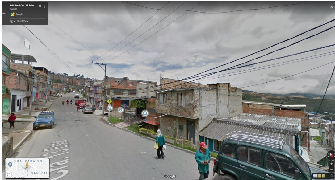
Figura 26 - Vista hacia costado sur manzana alternativa 3 – retorno Juan Rey.
