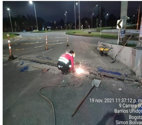
A la fecha, se continúan desarrollando actividades de demolición de las juntas de dilatación existentes, con el fin de remplazarlas por unas nuevas y se está a la espera de la aprobación por parte de la Interventoría de los niveles de empalme de la capa de rodadura de la rasante del pavimento de los accesos y salidas del intercambiador vial elevado.
