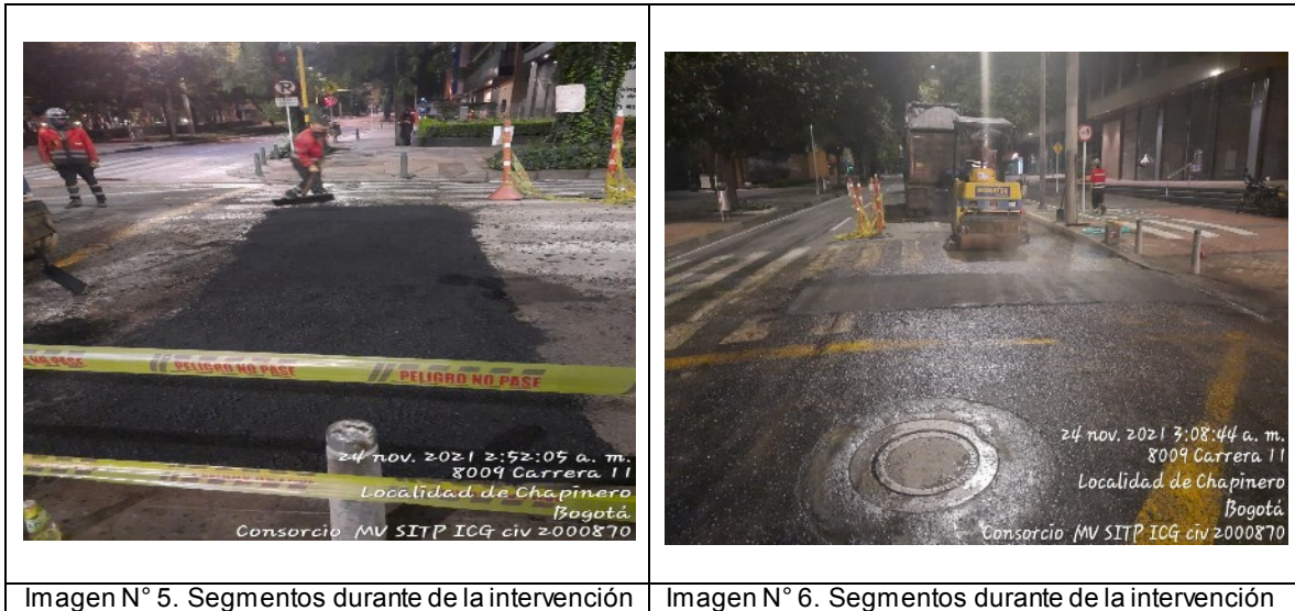
Imagen N° 5. Segmentos durante de la intervención
