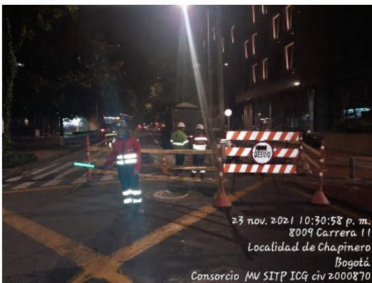
Imagen N° 3. Segmentos durante de la intervención
