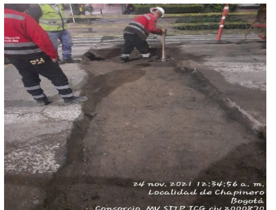
Imagen N° 4. Segmentos durante de la intervención
